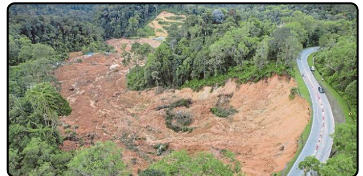
Rajah 4.4 : Kejadian tanah runtuh di Father Organic Farm Jalan Genting, Batang Kali, pada Disember 2022.
